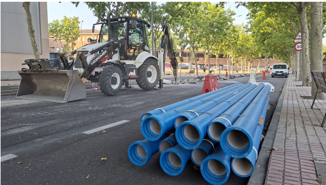
Renovación de tuberías de Salamanca AYUNTAMIENTO Europa Press
